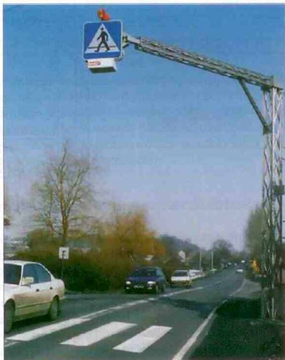
Fot. 1. Kratowe stalowe konstrukcje wsporcze
