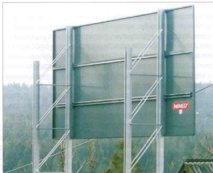
Fot. 2. Kratowe aluminiowe konstrukcje wsporcze
